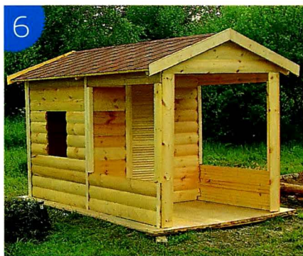
6 Всё как на настоящем доме: уложена кровля из мягкой черепицы, установлены ветровые доски, навешена дверь. Домик готов к покраске.
