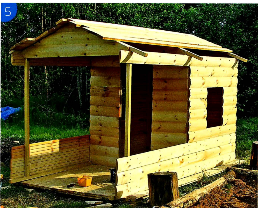
5 Устройство сплошного настила под кровлю.
