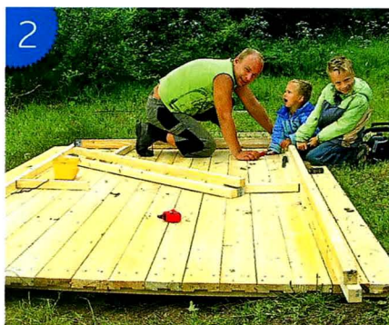
2 Основой для домика служит щит, сбитый из половых досок.
