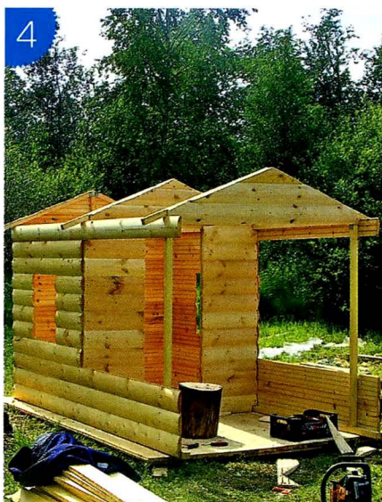
4 Домик обшит блокхаусом, который придаёт ему внешнее сходство с бревенчатой избушкой.
