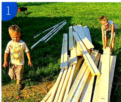
1 Стройматериалы завезены — пора приниматься за работу!
