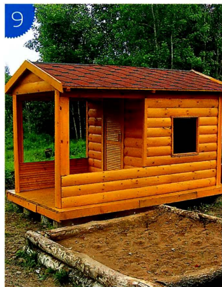
9 В последнюю очередь домик был поднят на фундамент из чурбаков, а по краю щита сделана декоративная «юбка».
