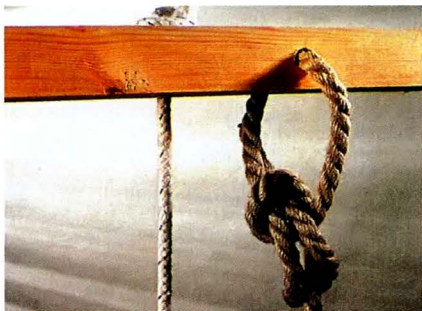
Канат качелей можно закрепить узлом, пропустив его через горизонтальное или вертикальное отверстие. В последнем случае качели выдерживают более высокие нагрузки.
